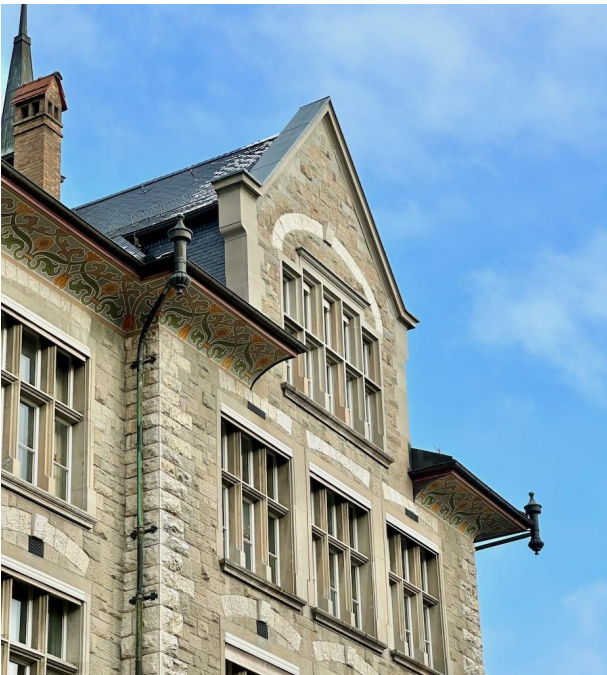
Een dakrand met uitkraging is akoestisch gunstiger dan een dakrand zonder details. Foto: Michiel Huijsman
