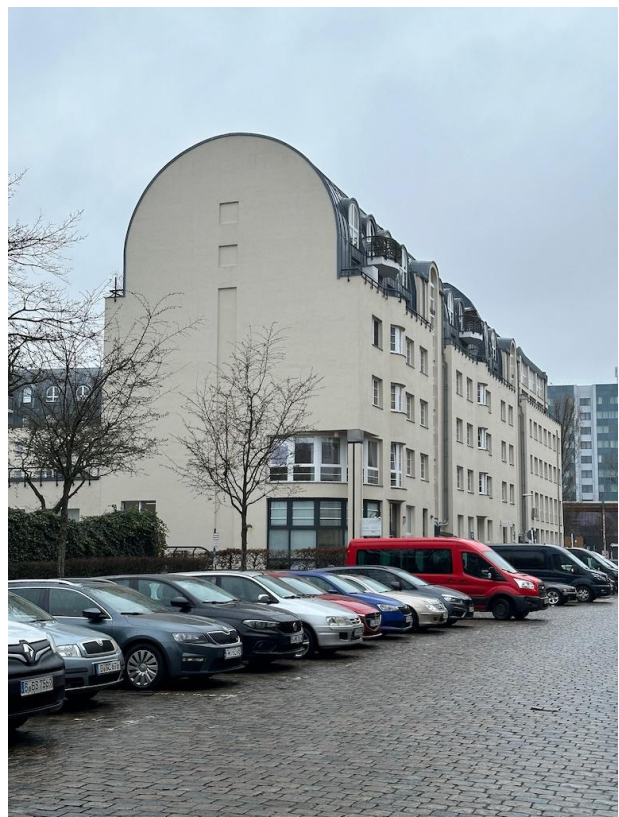
Gebouwen met ronde daken hebben een optimale afschermende werking. Foto: Michiel Huijsman
